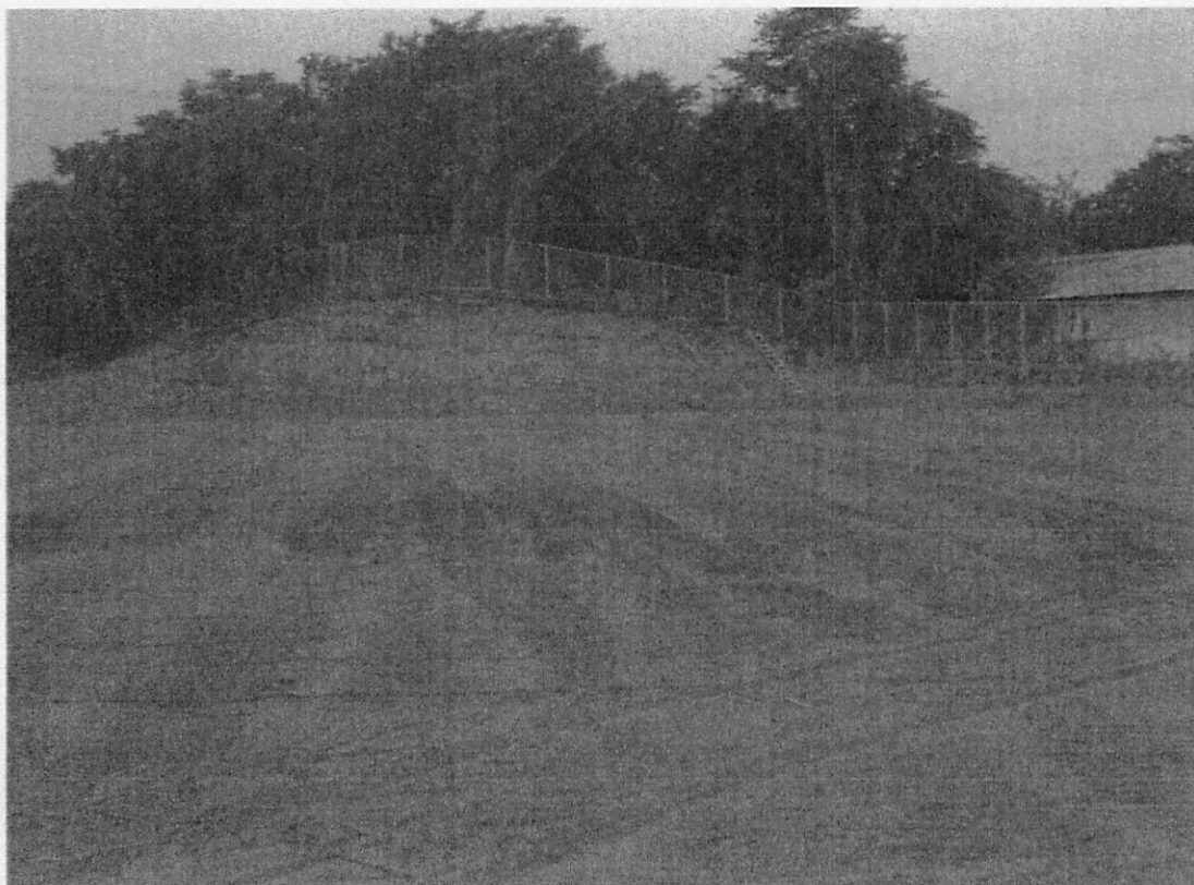
〔丘陵部掘削状況〕
